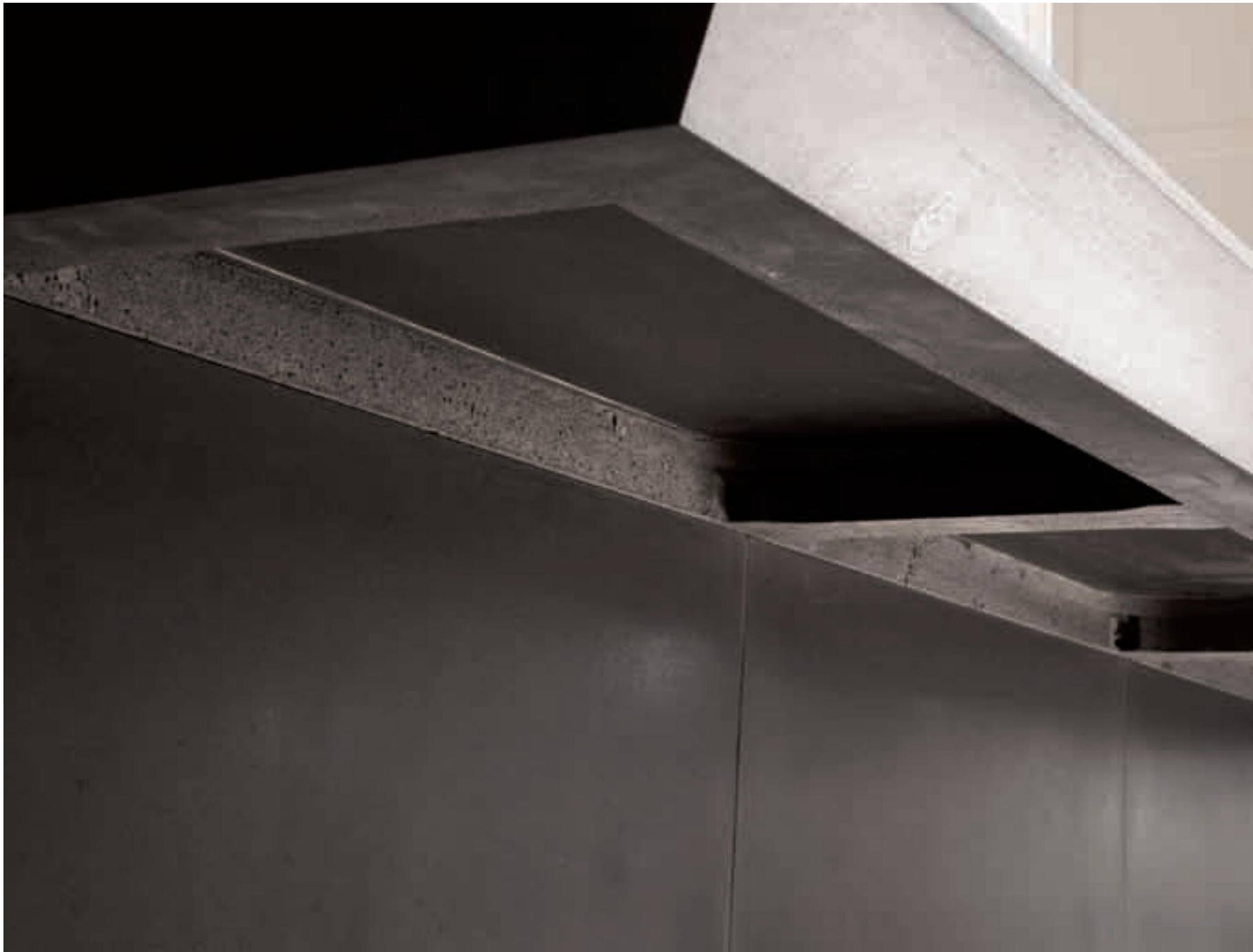
Particolare dello scavo sul retro del piano dell'isola per alleggerimento. Detail of the groove on the back of the island's countertop for lightening.
