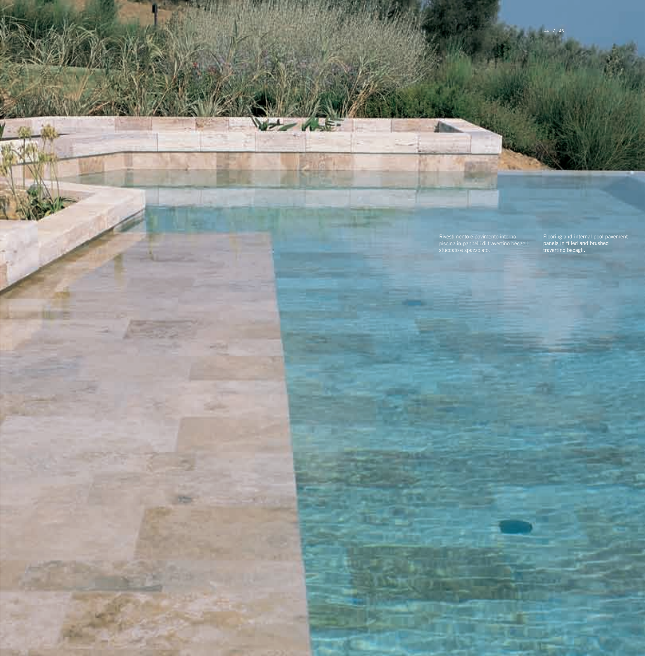
Design Vito Depalo Bordo a sfioro piscina realizzato in massello di travertino becagli a poro aperto spazzolato. Edge of swimming pool made in solid brushed open-pore travertino becagli.
