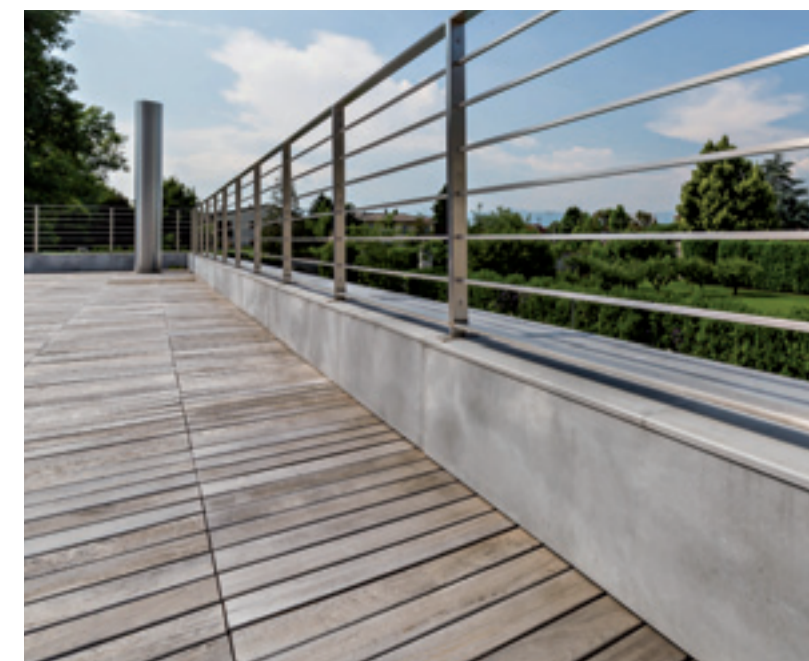
Terrazza solarium con rivestimento in legno ed alluminio délabré Solarium terrace in wood and délabré aluminium covering
